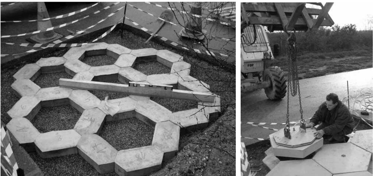
Figure 6 – La solution de Rouen: traverses en bois couvertes de géotextile sur lequel reposent les dalles. Les traverses sont posées manuellement, compte tenu de leur légèreté.
