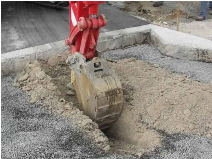
Figure 3 – Excavation de l'assise en GCR.
