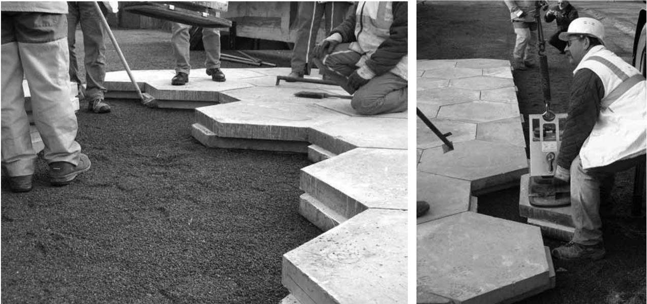
Figure 7 – La solution d'Autun (dalles emboîtées)
