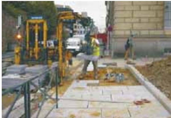
manutention au moyen de clés de levage
