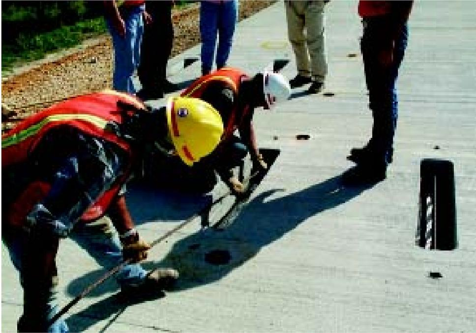
La précontrainte permet de réduire fortement l'épaisseur des panneaux. D'après les auteurs, une dalle de panneaux précontraints de 200 mm d'épaisseur remplirait les mêmes fonctions qu'une dalle traditionnelle de 355 mm.
