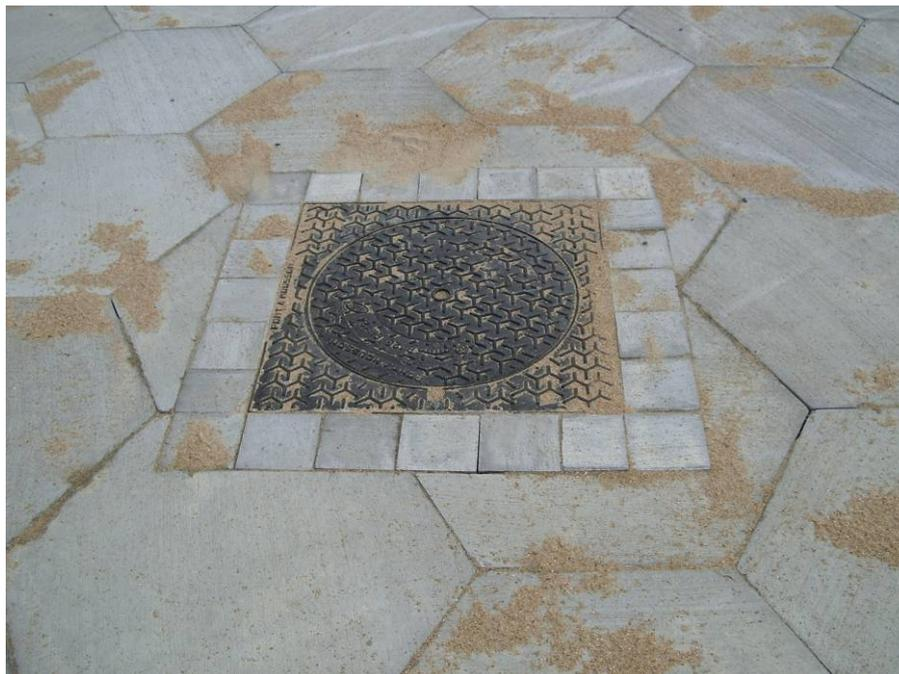
Figure 13 : exemple d'un regard pratiqué dans une CUD à dalles emboîtées. L'émergence est entourée d'une ligne de pavés, dont l'enlèvement permet le ripage horizontal et le démontage des dalles.
