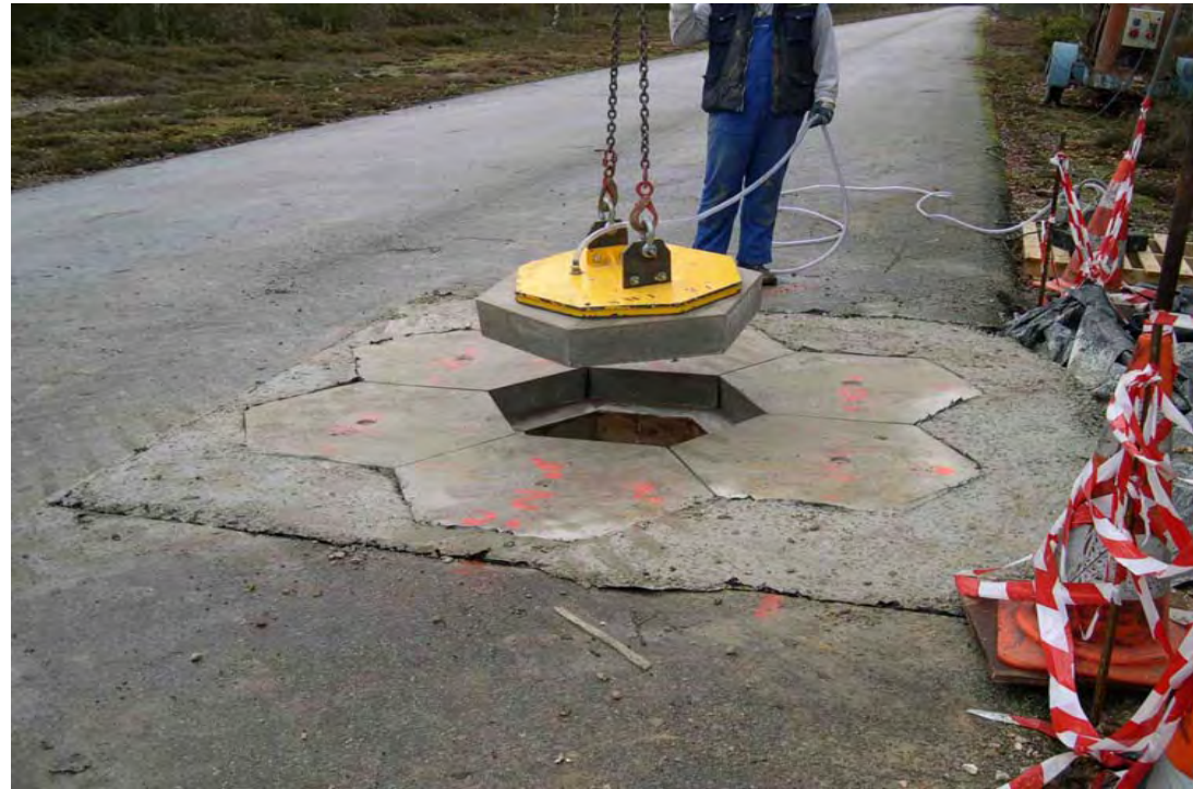
Opération Chaussées Urbaines Démontables
