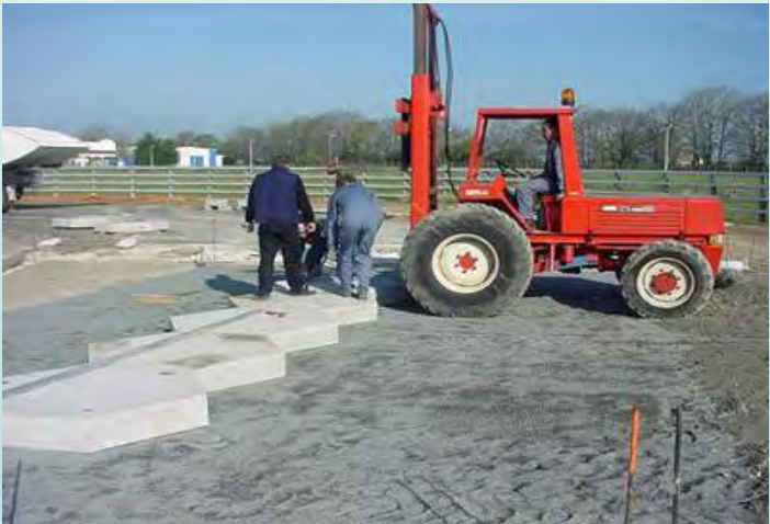
Pose des dalles sur gravillons 2/4 mm
