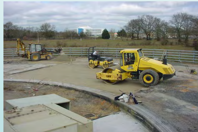
Mise en œuvre de la GC ré-excavable
