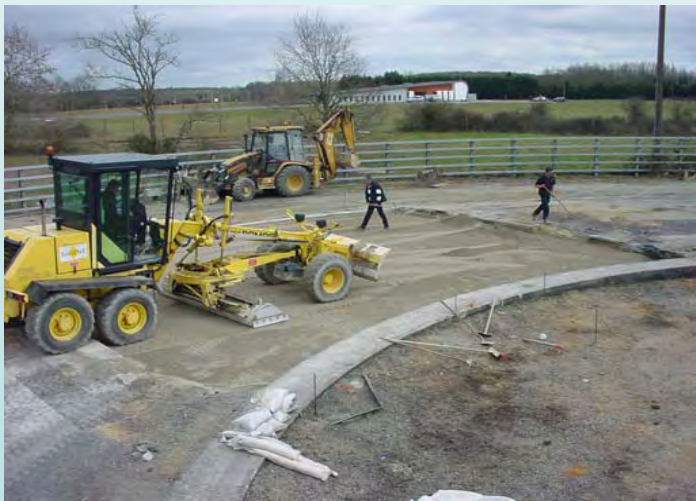
Mise en œuvre de la GC ré-excavable
