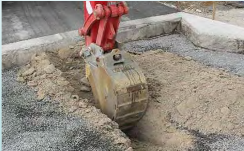
Essai de ré-excavabilité
