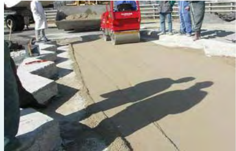
Compactage de la nouvelle GC
