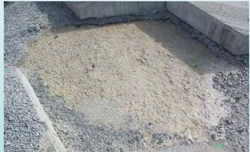
Absence de dégradation de la GC après 120 000 chargements lourds
