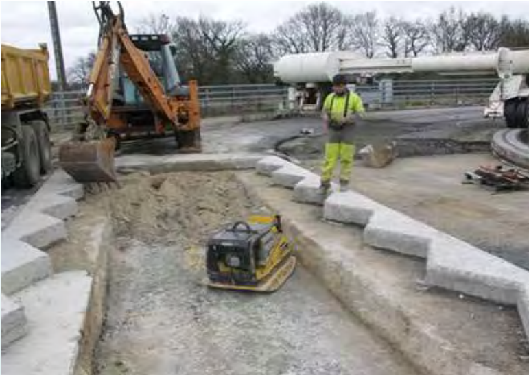
Excavation sur une largeur 2.20 m
