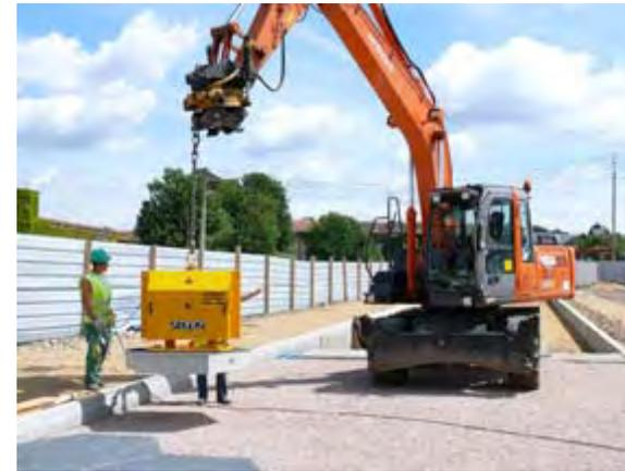
Un rebord de 1 cm de hauteur sur 15 cm de large en périphérie sur la face intérieure a été rajouté pour garantir un contact préférentiel avec le lit de pose.
