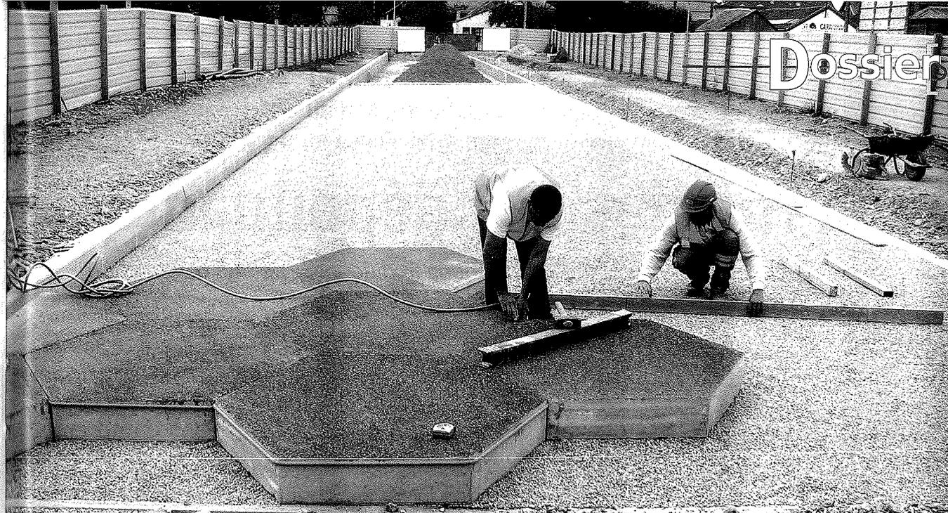
Réglage sur lit de pose et mise en place du joint élastomère entre les dalles déjà posées.
